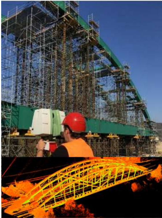
Obr. 1. Bezkontaktné terestrické laserové skenovanie a meranie deformácií inžinierskych konštrukcií
