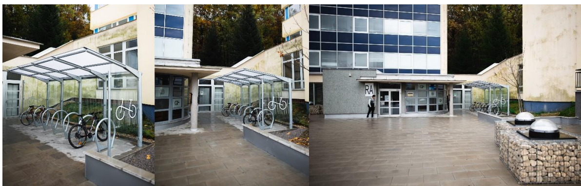
Obr. 32 Nový moderný prístrešok pre bicykle a elektrické kolobežky
