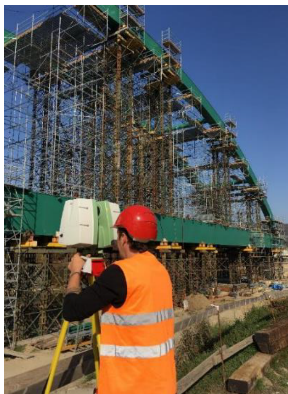
Obr. 12. Bezkontaktné terestrické laserové skenovanie a meranie deformácií inžinierskych konštrukcií
