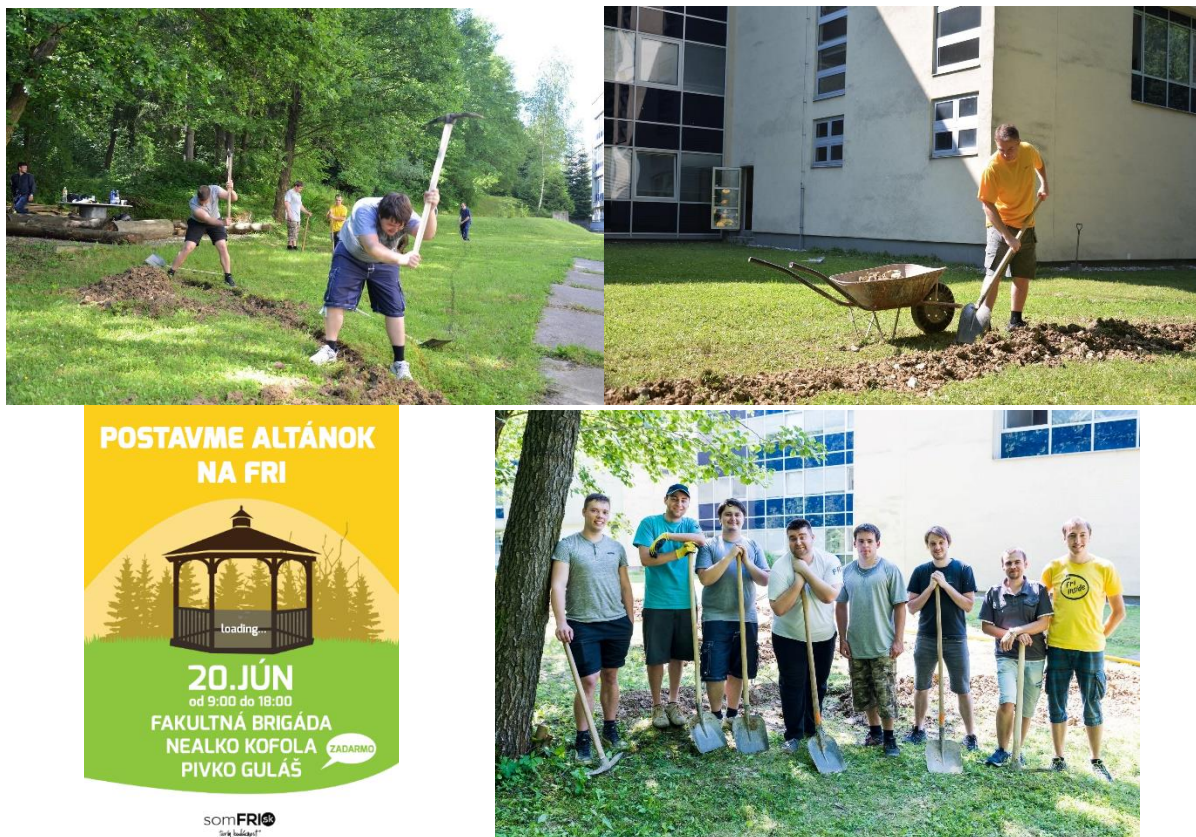
Obr. 23 Výstavba altánku FRI – I. etapa
