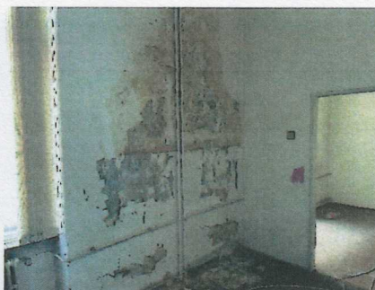
Lokálne poškodené (navlhnuté) vnútorné povrchy stien na prízemí (1.NP)
