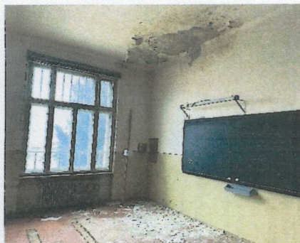
Lokálne poškodené (navlhnuté) vnútorné povrchy stropov a stien na 1.poschodí (2.NP)
