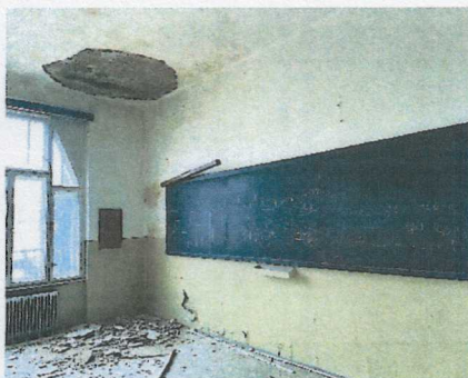
Lokálne poškodené (navlhnuté) vnútorné povrchy stropov a stien na 2.poschodí (3.NP)
