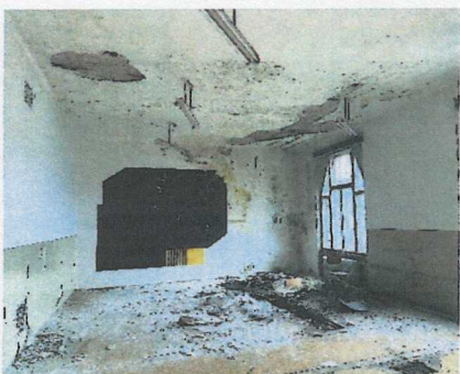
Lokálne poškodené (navlhnuté) vnútorné povrchy stropov a stien na 2.poschodí (3.NP)
