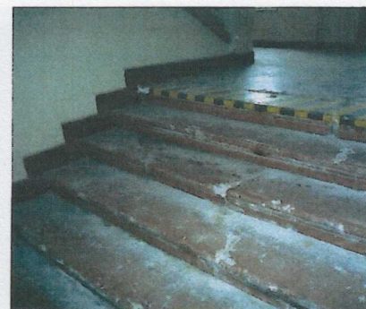
Lokálne poškodené (navlhnuté) vnútorné povrchy stien v suteréne (1.PP), poškodené stupne schodov do suterénu
