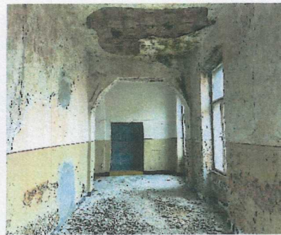
Lokálne poškodené (navlhnuté) vnútorné povrchy stropov a stien na 2.poschodí (3.NP)
