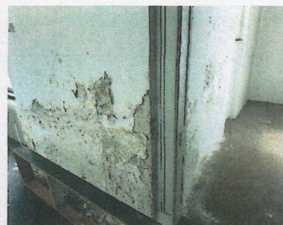
Lokálne poškodené (navlhnuté) vnútorné povrchy stien v suteréne (1.PP), poškodené stupne schodov do suterénu
