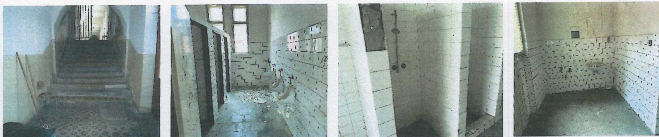
Vnútorne priestory v 1.NP – pôvodné priestory spojovacej chodby s telocvičňou, spoločných sociálnych zariadení
