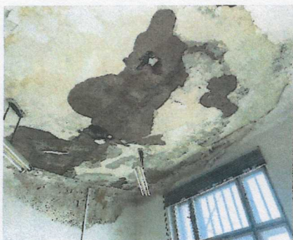
Lokálne poškodené (navlhnuté) vnútorné povrchy stropov a stien na 1.poschodí (2.NP)
