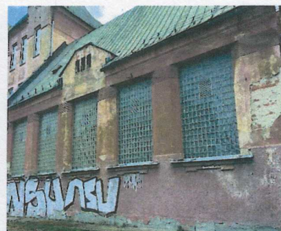
Lokálne poškodené (navlhnuté) fasádne povrchy objektu pôvodnej školy a telocvične
