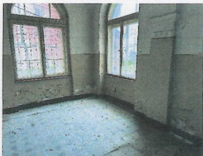
Lokálne poškodené (navlhnuté) vnútorné povrchy stien v suteréne (1.PP), poškodené stupne schodov do suterénu
