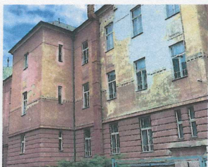
Lokálne poškodené (navlhnuté) fasádne povrchy objektu pôvodnej školy a telocvične
