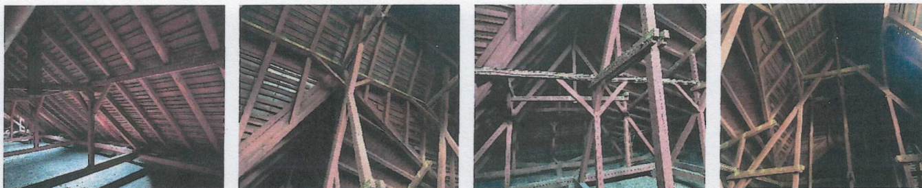
Vnútorné priestory povaly v objekte s detailmi krovu
