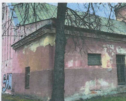
Lokálne poškodené (navlhnuté) fasádne povrchy objektu pôvodnej školy a telocvične
