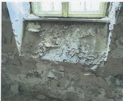
Lokálne poškodené (navlhnuté) vnútorné povrchy stien v suteréne (1.PP), poškodené stupne schodov do suterénu
