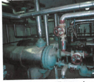
Vnútročné priestory v 1.PP ubytovacej časti - výmeniková stanica, dielňa a podzemný kolektor s rozvodmi
