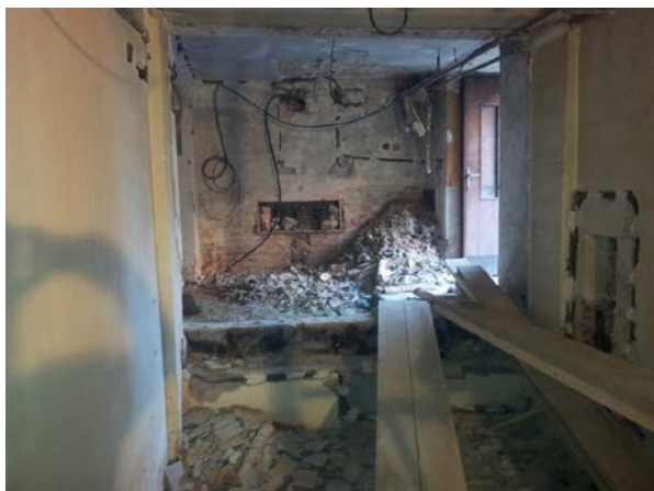
Obr.12 Priestory kotolne v budove A pri začatí prestavby
