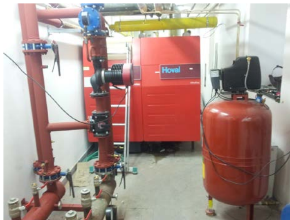
Obr.13 Nová technológia plynovej kotolne v budove A pri uvedení do prevádzky
