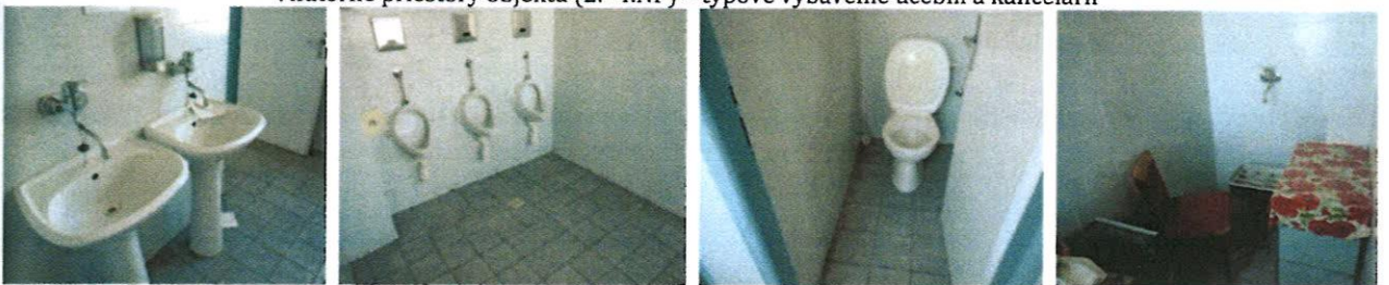
Vnútorne priestory objektu (2.- 4.NP) - typové vybavenie spoločných sociálnych zariadení
