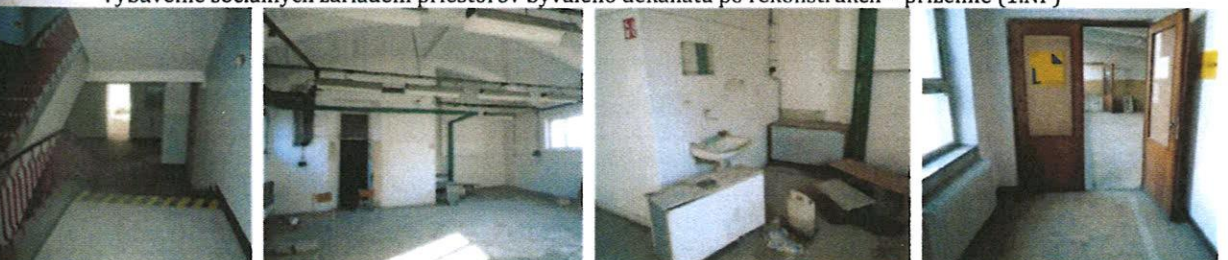
Vstup do južného krídla prístavby dielni, prechod do laboratórií- prízemie (1.NP)
