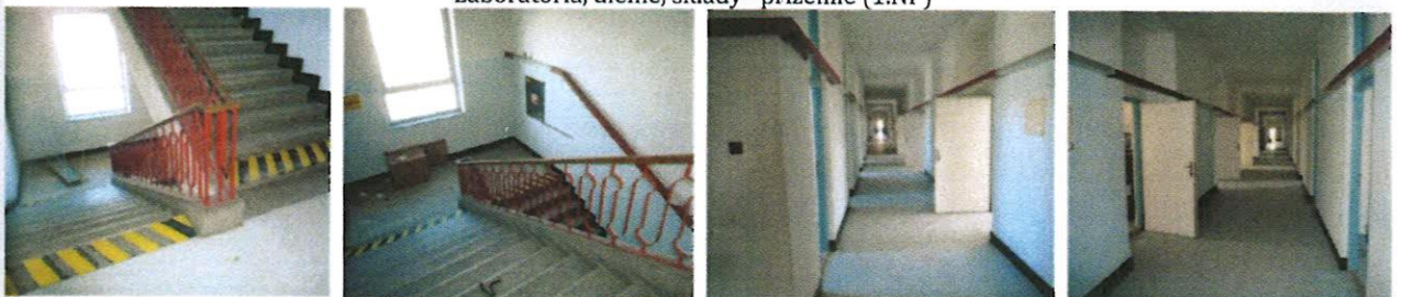
Vnútorne priestory objektu (2.- 4.NP) - schodiská, spoločné chodby
