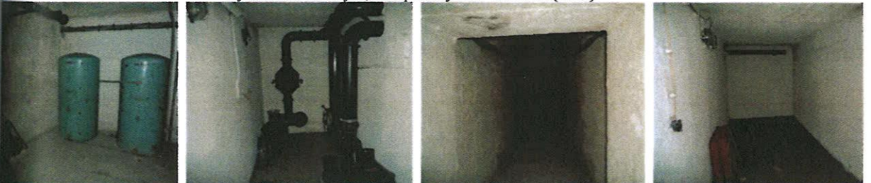
Vybavenie CO krytu, prelez medzi jednotlivými časťami, miestnosť úkrytu- suterén (1.PP)
