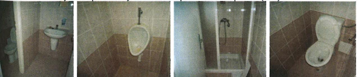
Vybavenie sociálnych zariadení priestorov bývalého dekanátu po rekonštrukcii - prízemie (1.NP)
