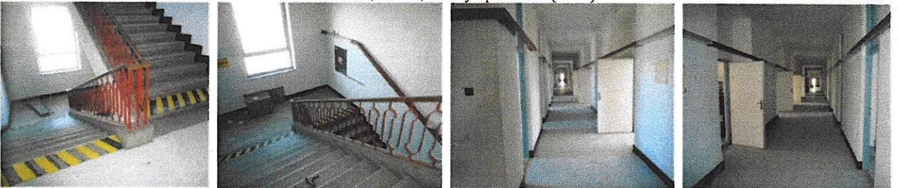
Vnútorne priestory objektu (2.- 4.NP) - schodiská, spoločné chodby
